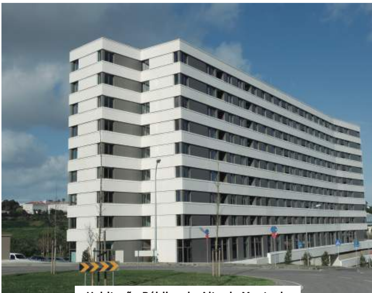
Habitação Pública do Alto da Montanha
